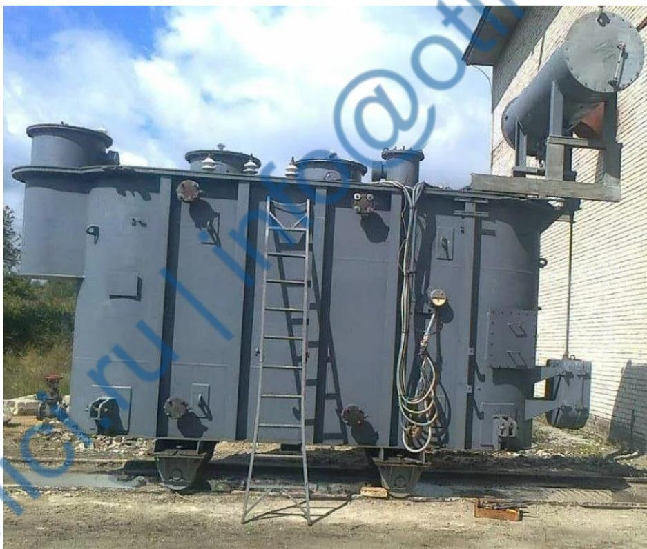
Рисунок 3 – Трансформатор ТМН-6300/110
